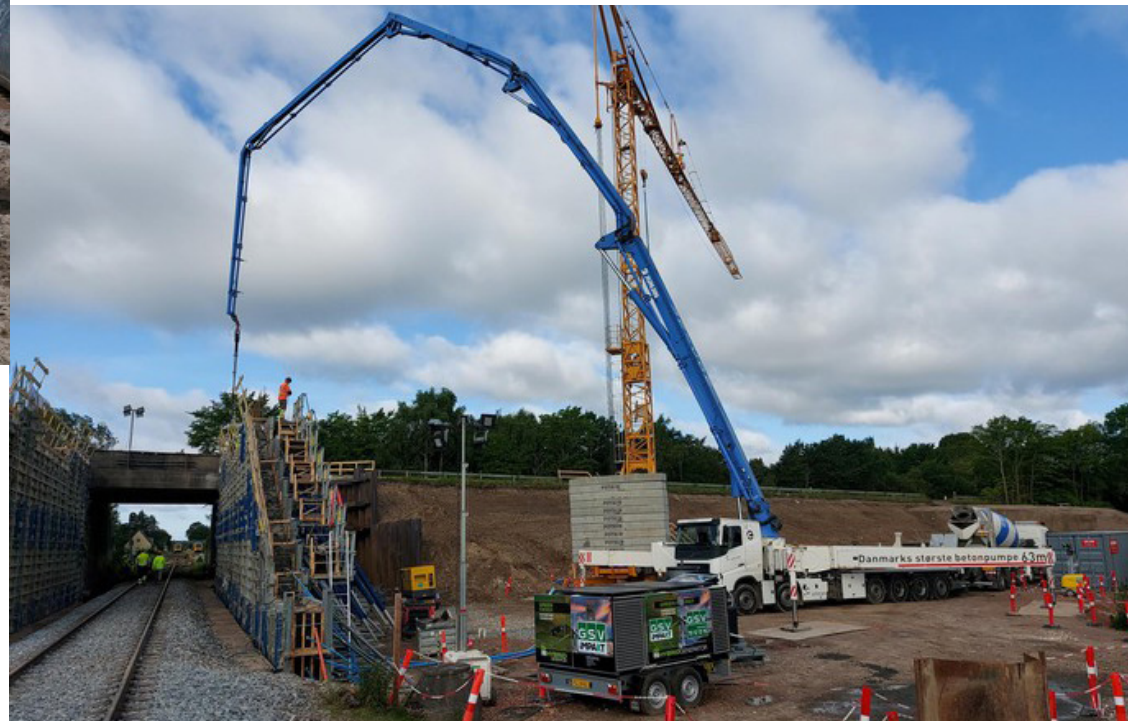
Anlægsarbejde på broen ved krydsningen af lokalbanen.
