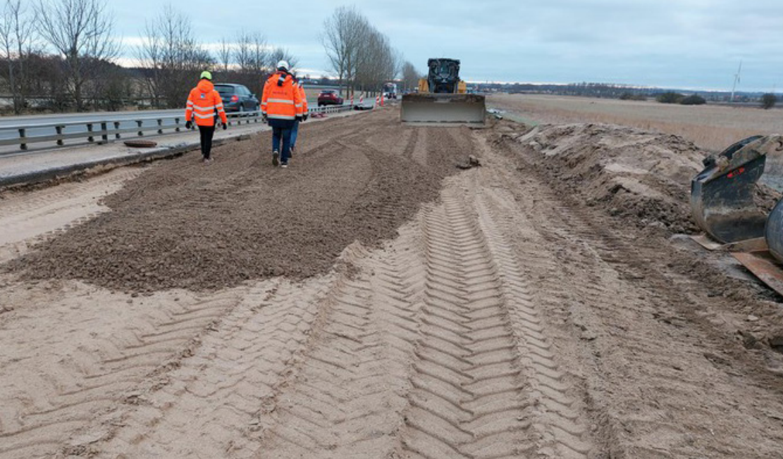
Anlægsarbejde ved den nye cykelsti langs Roskildevej.
