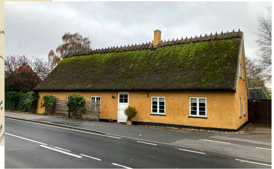
Freerslev Skole bygget omkring 1814 (Fotograf: Tom Feilberg 2022. BLF).
